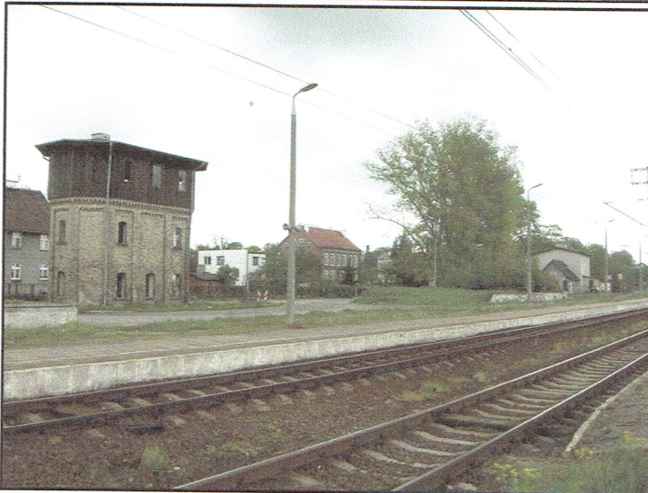
Dworzec PKP w Małdytach z zabytkową wieżą ciśnię (obecnie)
