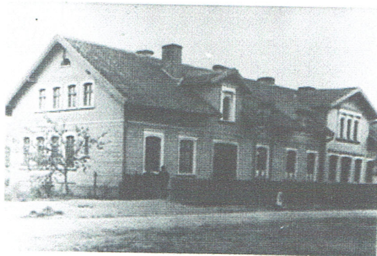
Przedwojeny budynek dawnej szkoły
