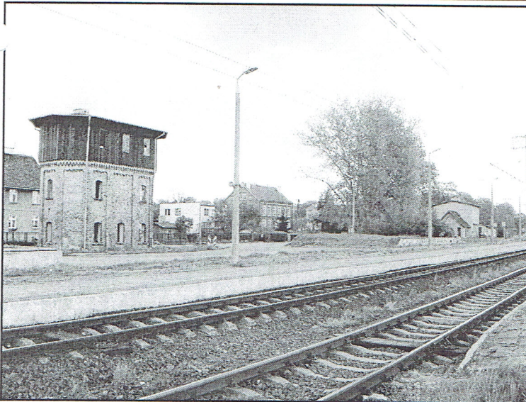
Dworzec PKP w Małdytach z zabytkową wieżą ciśnień (obecnie)
