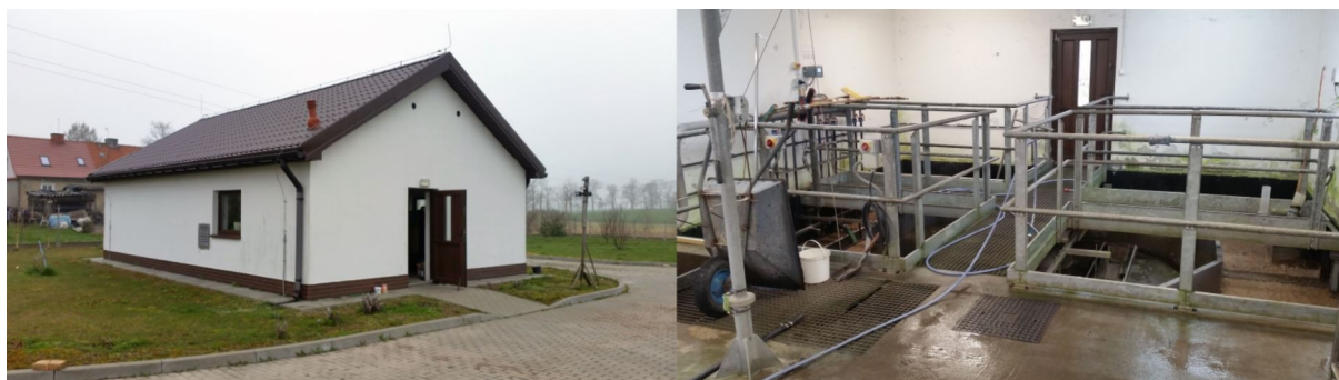
Rys. 3. Do zakresu działania Referatu GKMiR należy prowadzenie spraw z zakresu gospodarki wodnej, bieżącego utrzymania wodociągów i zaopatrzenia w wodę, kanalizacji, usuwania i oczyszczania ścieków komunalnych. Na zdjęciach gminna oczyszczalnia ścieków w miejscowości Kreki (źródło: archiwum Referatu GKMiR UG)
