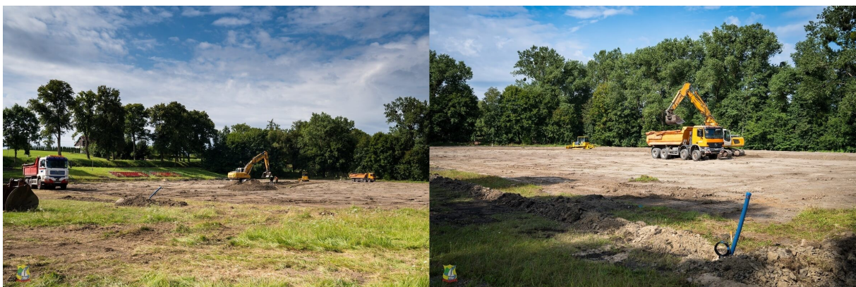
Rys. 4. Do zakresu działania Referatu GKMiR należy prowadzenie i obsługa gminnych inwestycji i remontów. Na zdjęciach początek przebudowy Stadionu w Małdytach (źródło: archiwum Referatu Promocji i Rozwoju Lokalnego)
